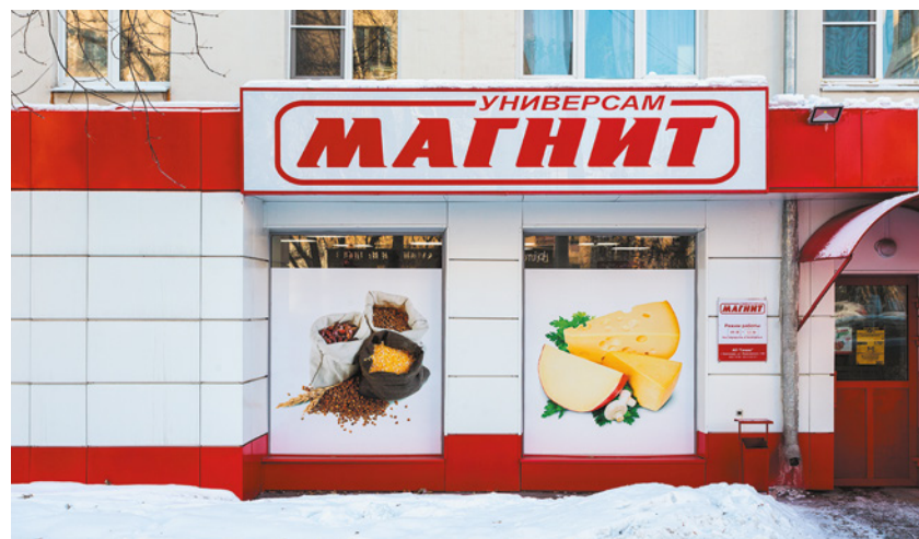
Отделка фасада профилированным металлическим листом
