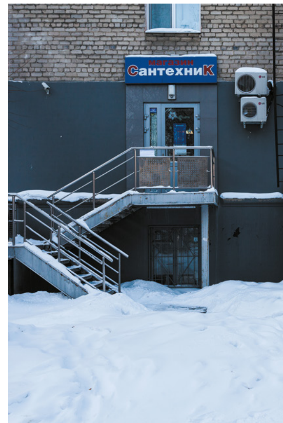
Пример превышения допустимой высоты уровня входа
