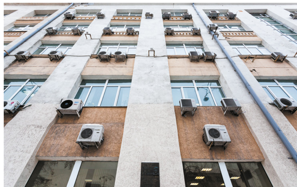
Пример неправильного размещения кондиционеров на фасаде здания
