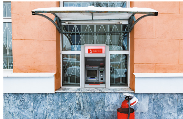
Пример расположения банкомата в оконном проеме
