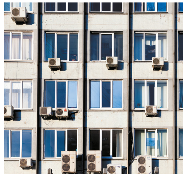
Пример неправильного размещения кондиционеров на фасаде здания
