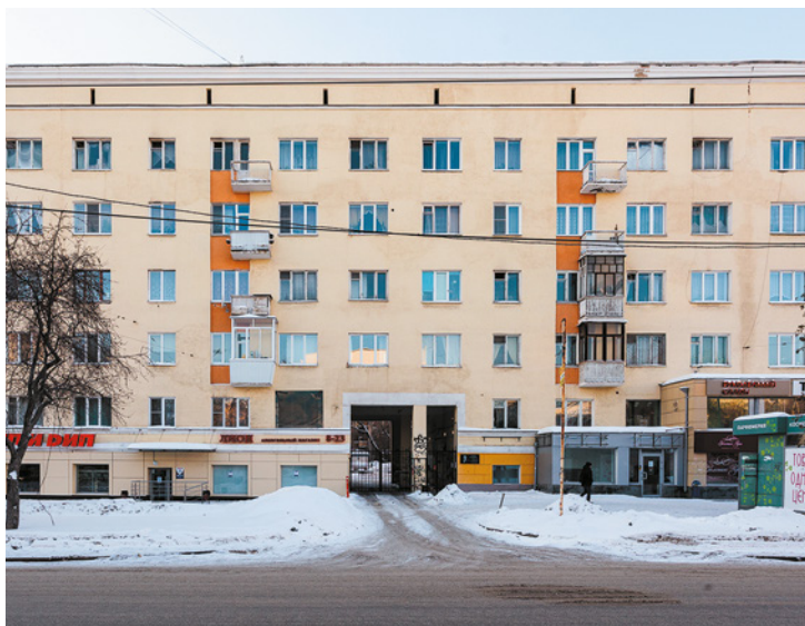
Пример балконного остекления, которое противоречит изначальному архитектурному облику здания
