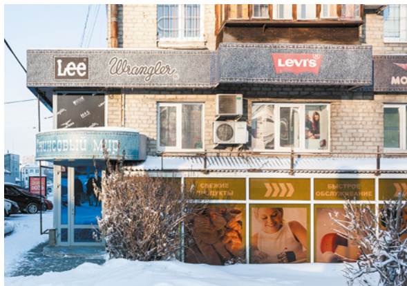
Пример входной группы с использованием пристроенного тамбура
