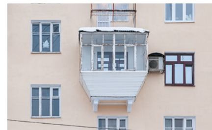
Пример изменения формы балкона, которая противоречит изначальному архитектурному облику здания
