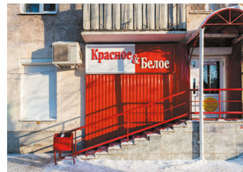
Отделка фасада профилированным металлическим листом
